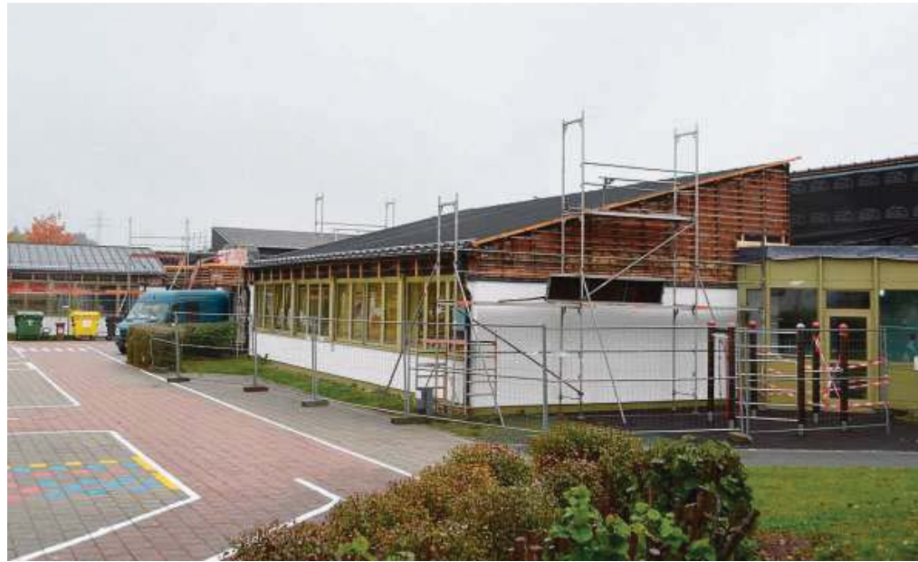
Die Sanierung der Tauperlitzer Grundschule dauert an. Laut Bürgermeister Marc Ultsch laufen die Arbeiten ohne große Probleme und liegen im Zeitplan. Für die Mittagsbetreuung wurden Container bestellt, die voraussichtlich Ende Januar geliefert werden.
